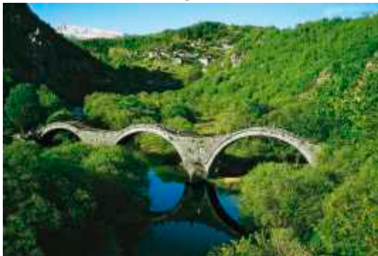
Kipi - Plakidas Bridge
